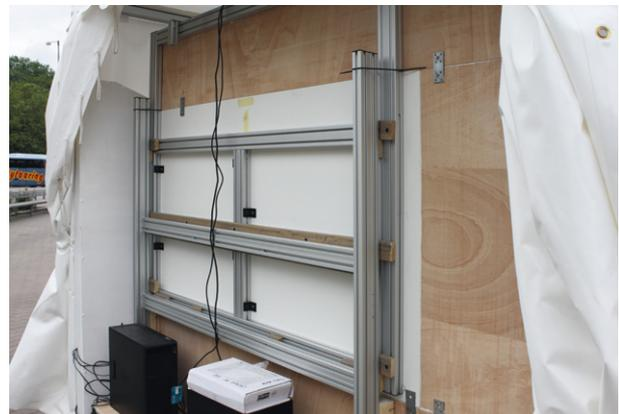
Bild 23: Konstruktion der mobilen Multimediawand
